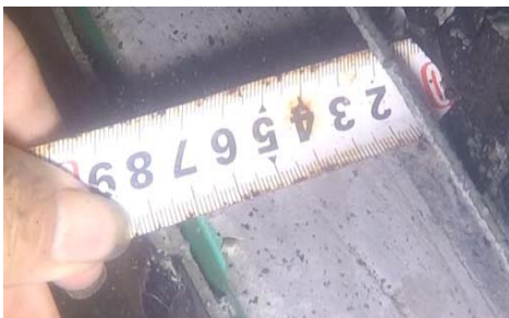
Hình 15: Vữa sửa chữa sau khi bơm
