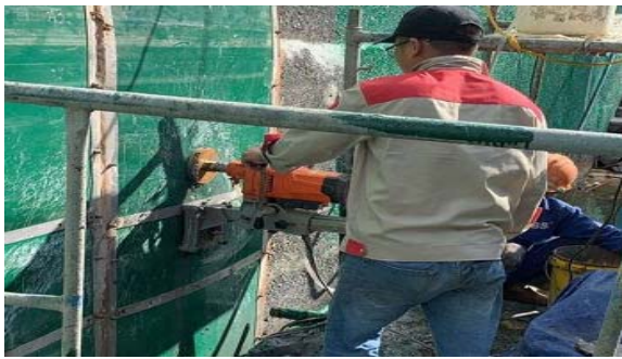
Hình 9: Khoan rút lõi lấy mẫu vữa
