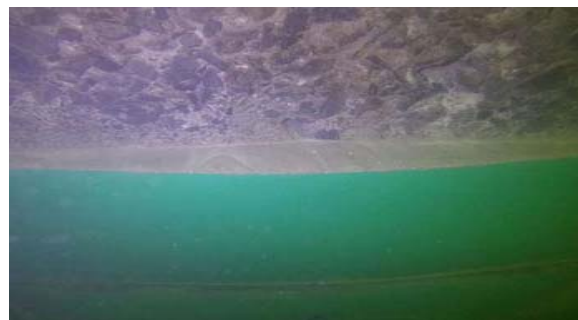
Hình 8: Bơm đầy vữa giữa khoảng hở với tấm màng
