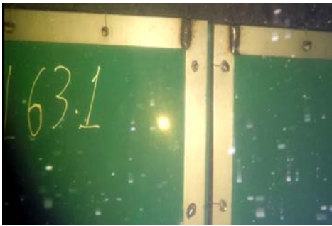
Hình 13: Lắp đặt màng cách nước
