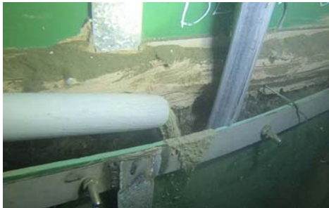
Hình 14: Vữa sửa chữa được bơm dưới nước
