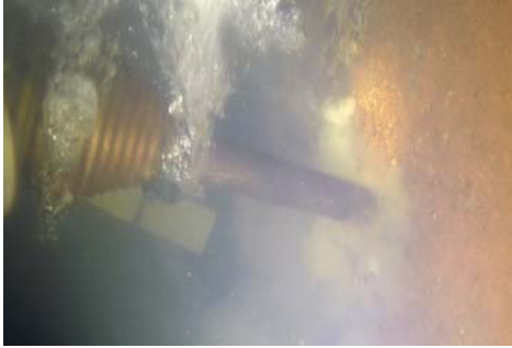
Hình 12: Đục tạo nhám cho bề mặt bê tông
