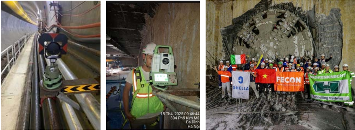
Hình 3.2: Một số hình ảnh đo lưới đường chuyển kép trong hầm đoạn S9 - S10
