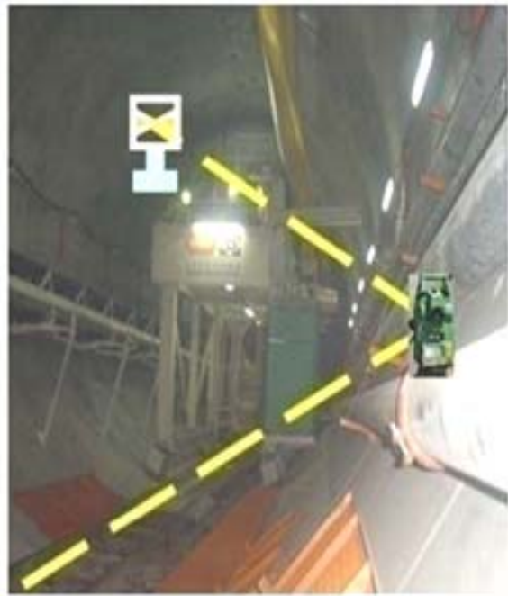
Hình 1.3: Lưới đường chuyền kép trong hầm
