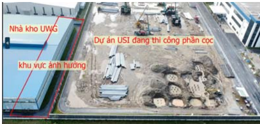
Hình 2: Khu vực tiếp giáp với dự án đang thi công
