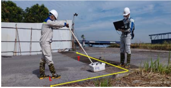
Hình 1: Khảo sát công trình ngầm bằng công nghệ Radar xuyên đất tần số kép (200 - 600 MHz)
