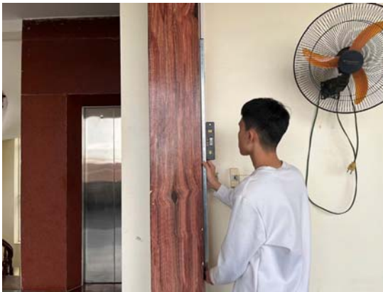
Hình 3: Sử dụng thước Nivo cân bằng điện tử để đo độ nghiêng trụ đứng các trụ đứng ở vị trí góc công trình
