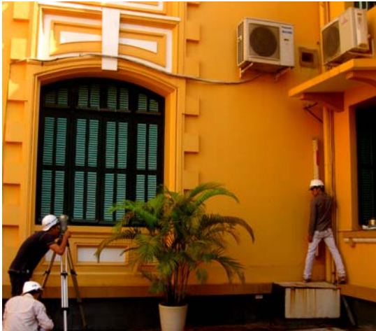
Hình 2: Đo nghiêng các trụ đứng tại vị trí góc công trình bằng máy toàn đạc điện tử Trimble M1
