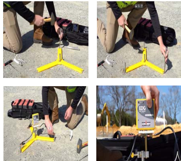
Hình 14: Lắp đặt thiết bị EDGe hiện trường
