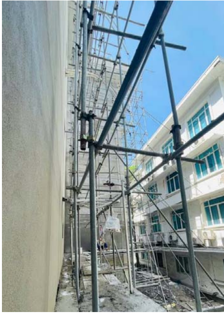
Hình 5: Khoá giáo liên kết ống thép rời trên công trình
