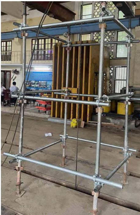
Hình 6: Kết cấu chống đỡ tạm sử dụng khoá giáo góc vuông liên kết ống thép rời
