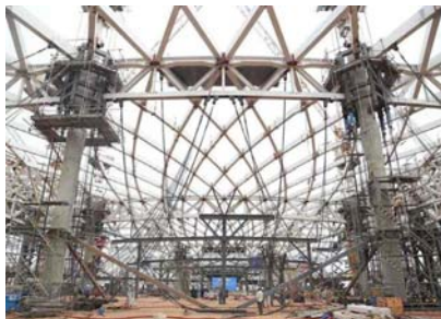
a) Hình ảnh thực tế quá trình kéo nâng mái thép
