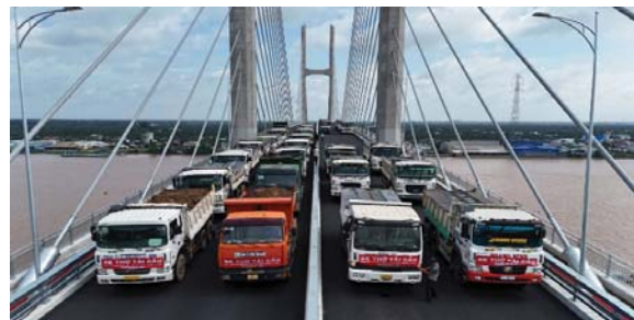
Hình 1: Thử tải cầu Rạch Miễu 2 [11]
