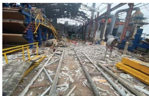
Hình 5: Cháy nổ bụi trong nhà công nghiệp
