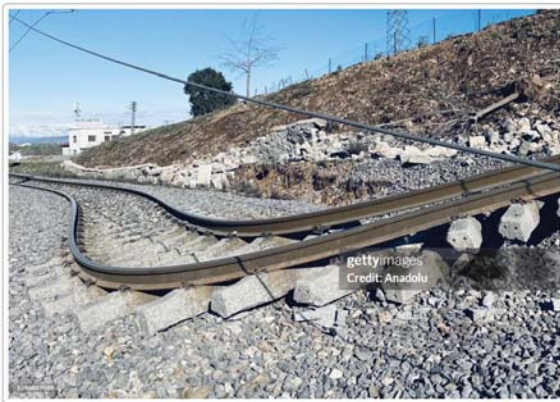
Hình 1: Đường ray bị uốn cong và dịch chuyển sau trận động đất lớn (Thổ Nhĩ Kỳ, 2023)
