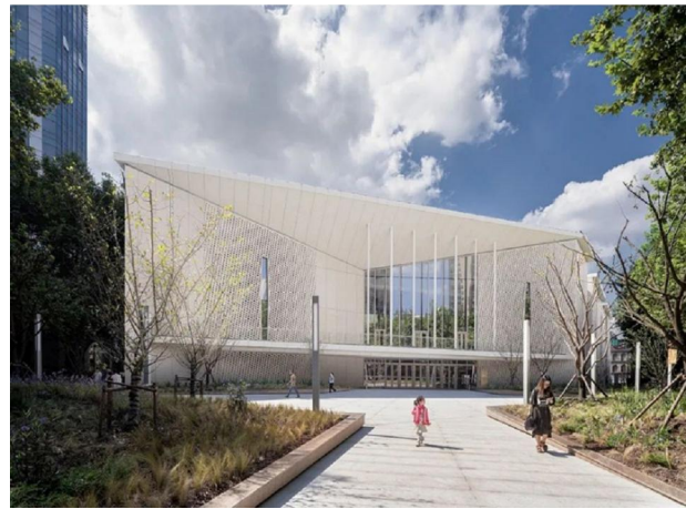
Hình 5: Nhà hát lớn Hàng Châu (Yuhang Grand Theatre) - công trình tiên phong ứng dụng UHPC tại Trung Quốc, với kết cấu “khung chịu lực + bê tông cốt thép” và lớp vỏ UHPC mô phỏng vết nứt tự nhiên, tạo hiệu ứng thị giác mạnh mẽ và giảm chi phí bảo trì (Ảnh Internet)
