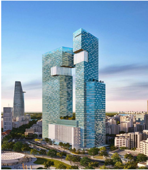
Hình 1: Dự án “The One”, Thành phố Hồ Chí Minh: Ứng dụng panel UHPC cho mặt dựng nhằm giảm tải trọng và tăng khả năng chịu nhiệt. (Ảnh Internet)
