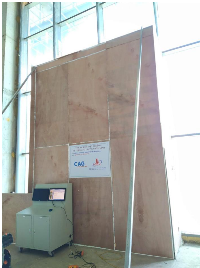
Hình 9. Thử nghiệm độ lọt khí tại hiện trường
