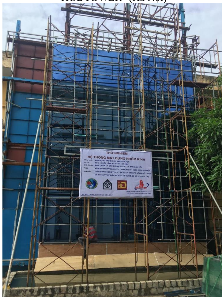
Hình 11. Thử nghiệm hệ mặt dựng nhôm kính của công trình "XÂY DỰNG TRỤ SỞ ỦY BAN DÂN TỘC" (2017)
