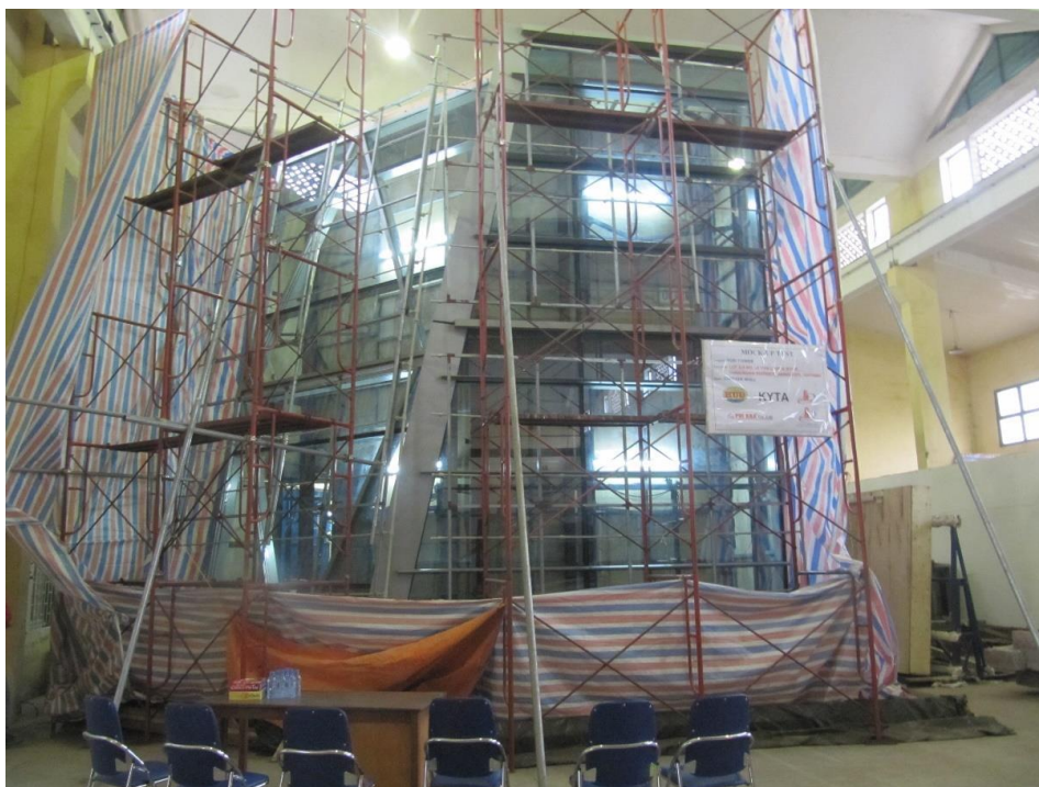
Hình 6. Thử nghiệm hệ mặt dựng nhôm kính của công trình "TÒA NHÀ VĂN PHÒNG HUDTOWER" (Hà Nội)
