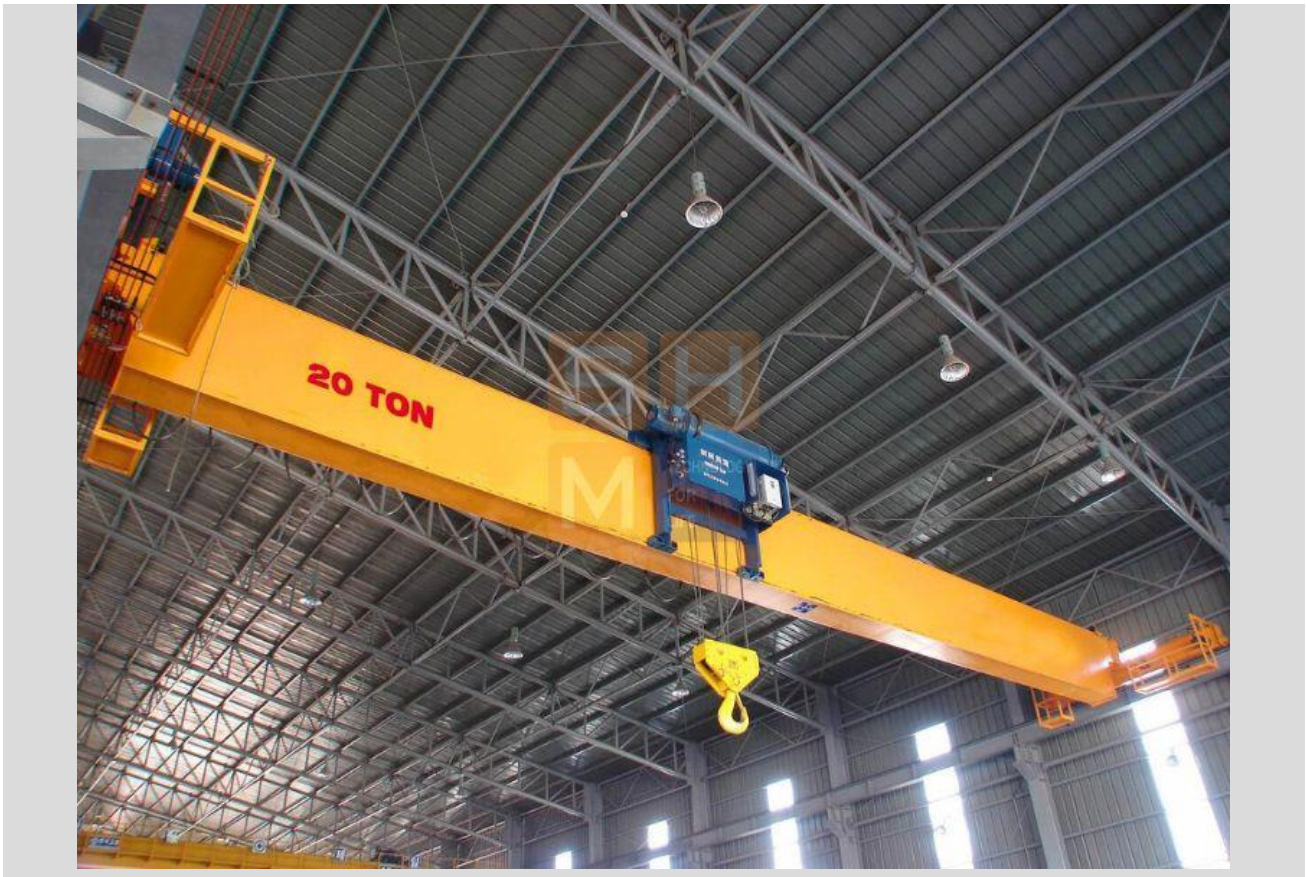
Hình 1 – Hình ảnh cầu trục dầm đơn
