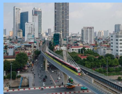
Khảo sát BCS Tuyến đường sắt Nhôn – Ga Hà Nội
