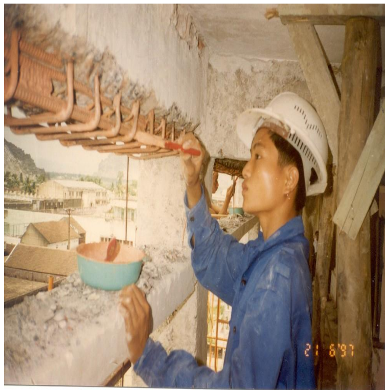
Thi công sửa chữa chống ăn mòn bê tông cốt thép
