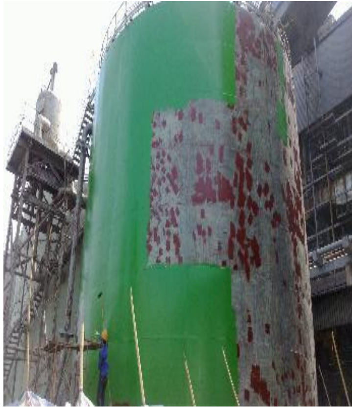
Thi công sơn chống ăn mòn kết cấu thép
