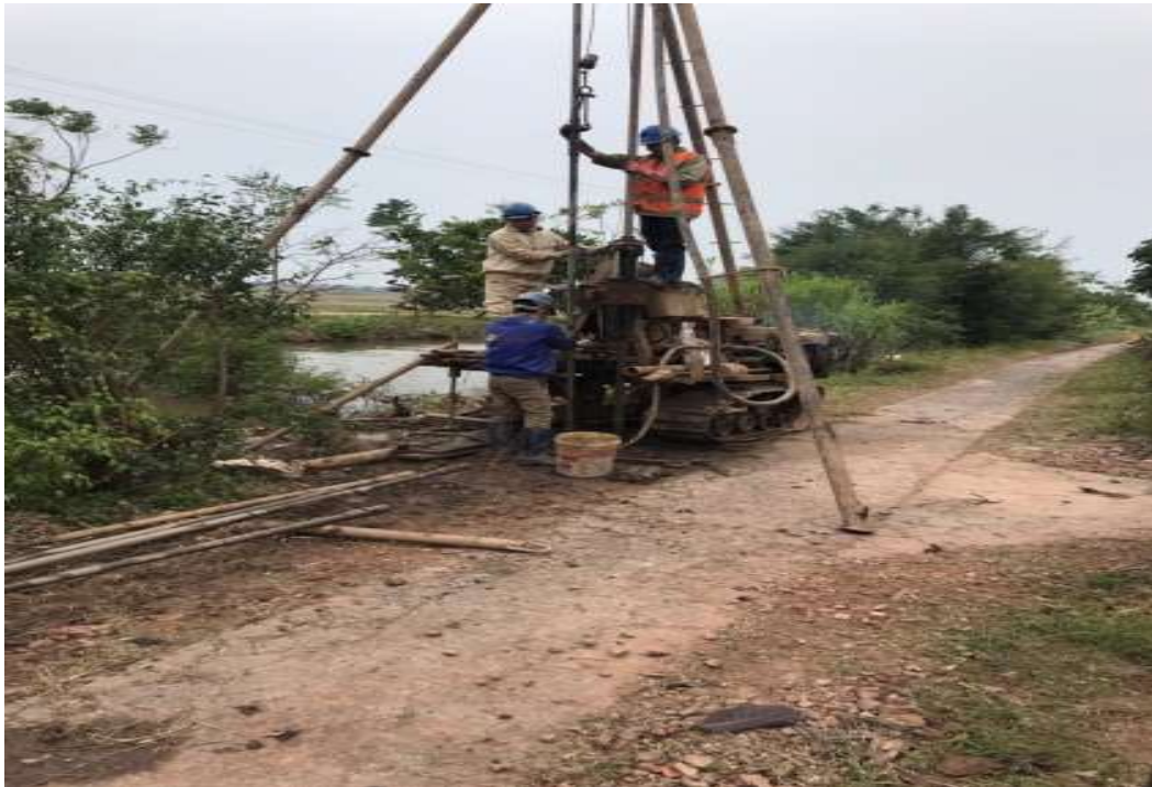
Hình 3.2. Hình ảnh hố khoan đang thi công lấy mẫu
