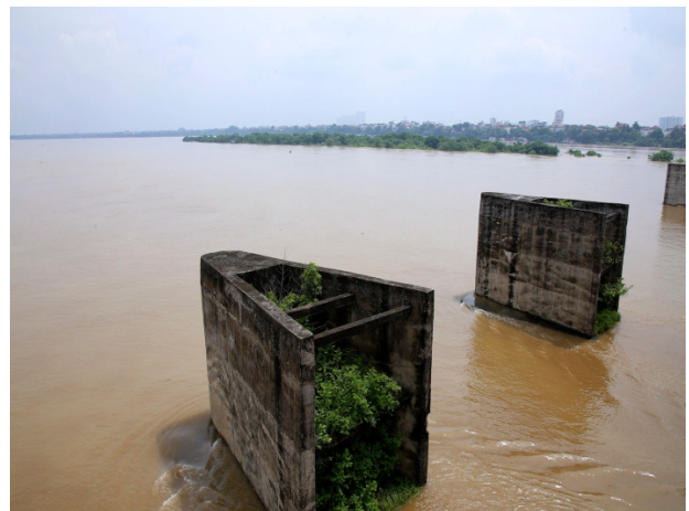
Hình 3. Mổ phân dòng trụ cầu Long Biên
