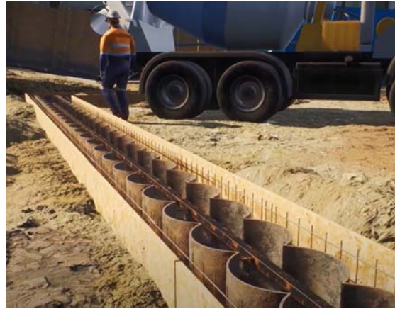
Hình 5. Hình ảnh minh họa thi công tường dẫn
