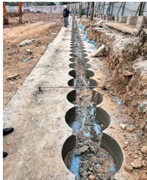
Hình 6. Hình ảnh thực tế tường dẫn sau khi thi công
