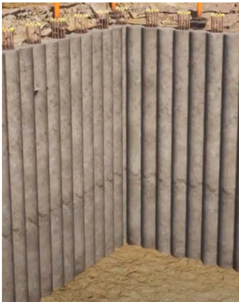
Hình 4. Hình ảnh minh họa tường Secant pile sau khi hoàn thiện
