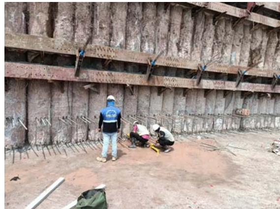
Hình 10. Hình ảnh thực tế của tường Secant Pile sau khi hoàn thiện
