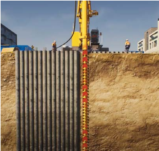
Hình 7. Hình ảnh minh họa cho công tác khoan tạo lỗ cọc chính (cọc không có cốt thép)
