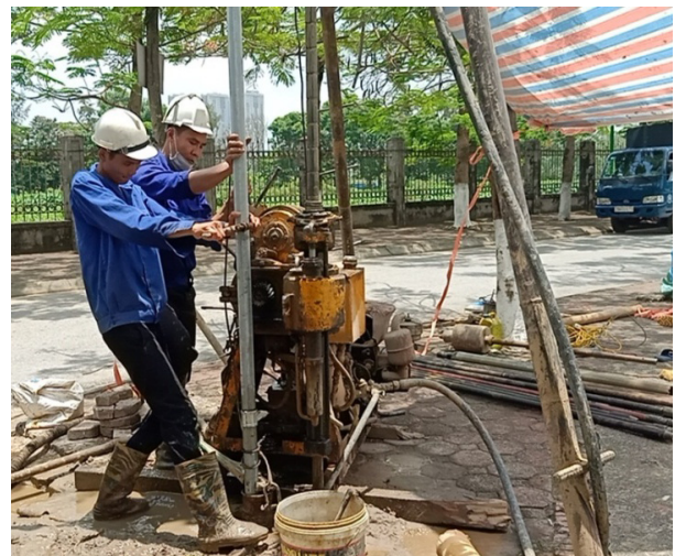
Hình 1. Công tác khoan và hạ ống thân mốc chuẩn
