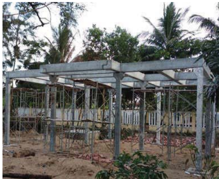
b) Thi công lắp dựng cột, dầm nhà 1 tầng
