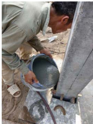
a) Thi công lắp dựng cột nhà 1 tầng
