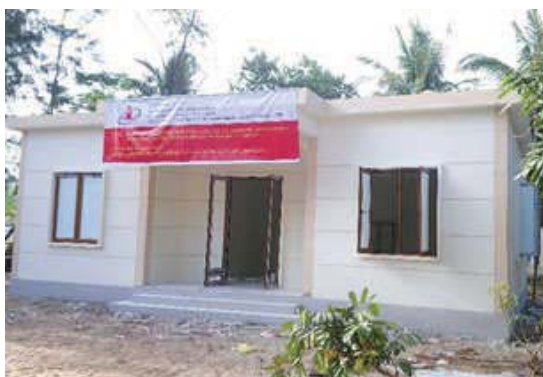
Hình 13. Hoàn thiện nhà 1 tầng tại xã Hoàng Phụ, huyện Hoàng Hóa, tỉnh Thanh Hóa
