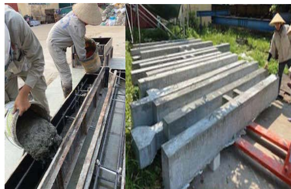
Hình 12. Sản xuất dầm, cột BTCS PVA với cốt gia cường Bazalt
