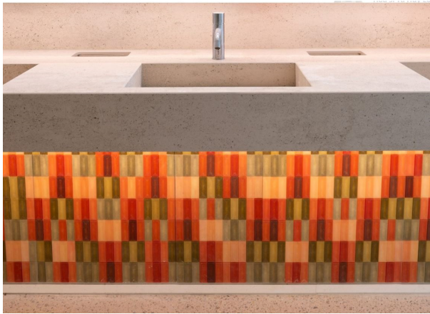
Hình 12. Những viên gạch tảo ép được ốp tại phòng tắm trong tòa tháp The Tower của KTS Frank Gehry ở Arles, Pháp.
