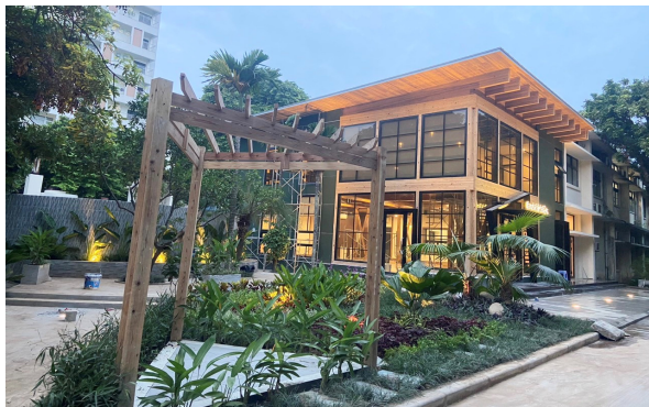
Hình 14. Công trình Nhà mẫu kết cấu gỗ CLT
