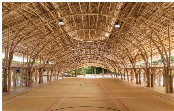
Hình 8. Nhà thi đấu trường Panyaden (Thái Lan)
