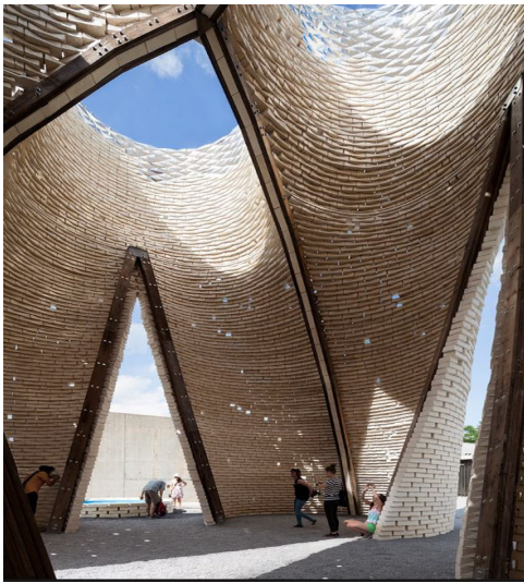
Hình 2. Hy-Fi, cấu trúc quy mô lớn đầu tiên được làm bằng gạch sợi nấm [4]
