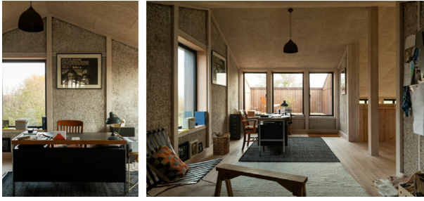
Hình 11. Tường bằng bê tông gai dầu ở công trình Flat House [13]
