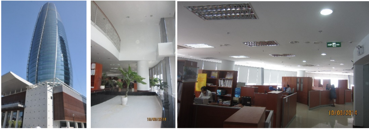
Hình 6. Trung tâm hành chính Đà Nẵng: a- Nhìn bên ngoài: tòa nhà được bao bằng vỏ kính, ĐHKK 100% không gian; b- Một “hiên kín” thông 2 tầng; c- Không gian làm việc mở và che rèm cửa, dùng ánh sáng điện
