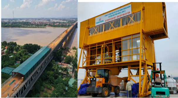
Hình 9. Nhà thi công lớp phủ có mái che và trạm trộn tại mặt cầu
