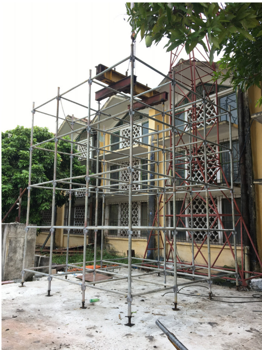
Hình 7. Hình ảnh thử tải kết cấu chống đỡ tạm
