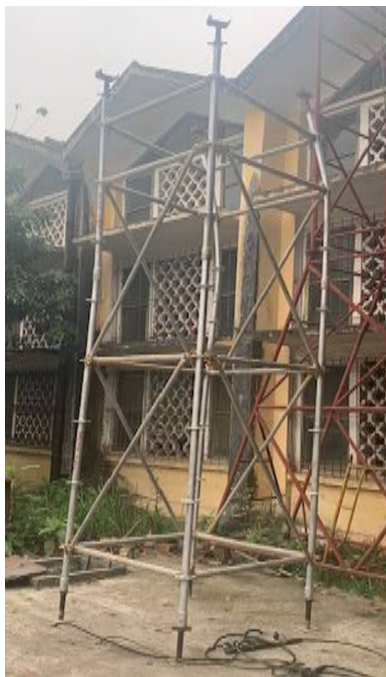
Hình 3. Hình ảnh kết cấu chống đỡ tạm khi phá huỷ
