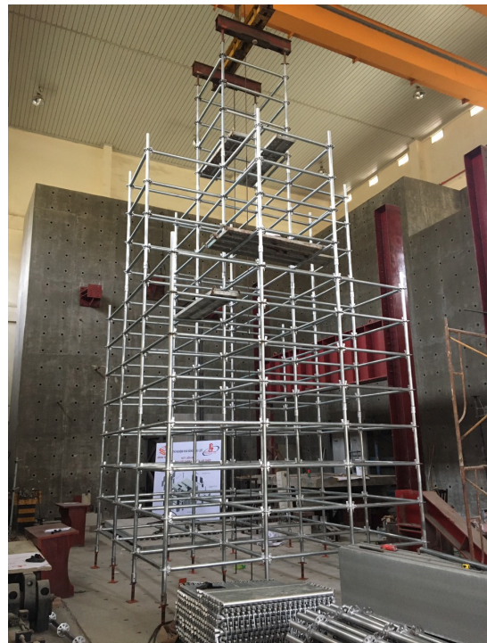
Hình 9. Hình ảnh thử tải kết cấu chống đỡ tạm
