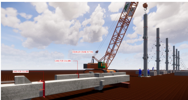
Hình 5. Lắp ghép cột bê tông (đúc sẵn trong nhà máy)
