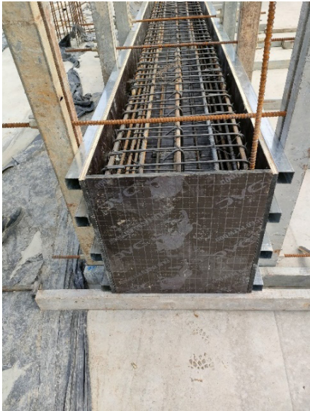
Hình 12. Lắp dựng cốt thép, cốp pha
