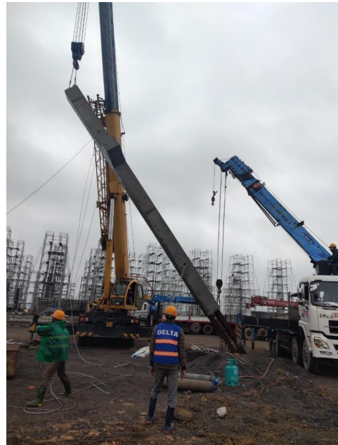
Hình 15. Chuyển cột từ trạng thái nằm ngang sang trạng thái thẳng đứng
