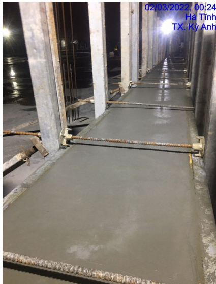
Hình 13. Đổ bê tông cột tại mặt đất
