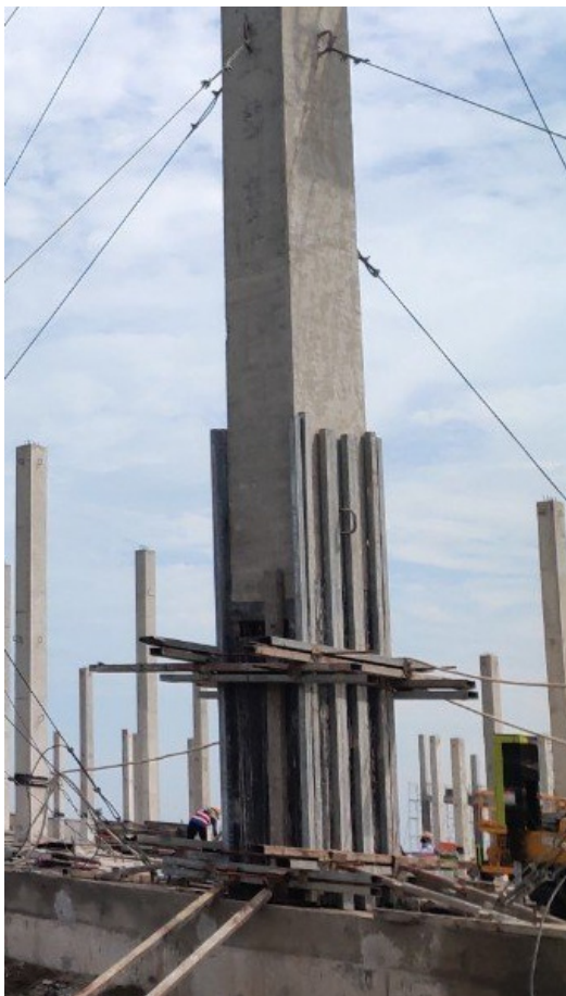
Hình 19. Ghép cốt pha phần chân cột phía dưới
