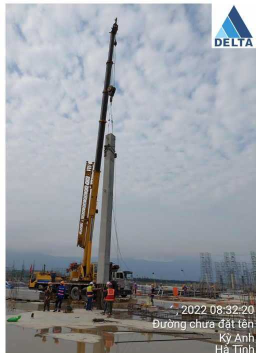
Hình 16. Cầu tự hành giữ cột thẳng đứng
