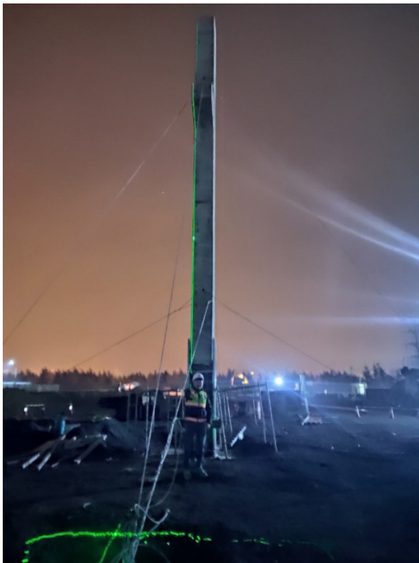
Hình 18. Bật mực và căn chỉnh cột
