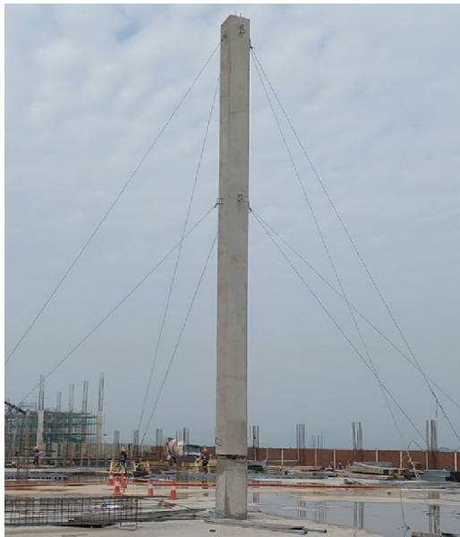
Hình 20. Hình ảnh đã đổ bê tông chân cột
