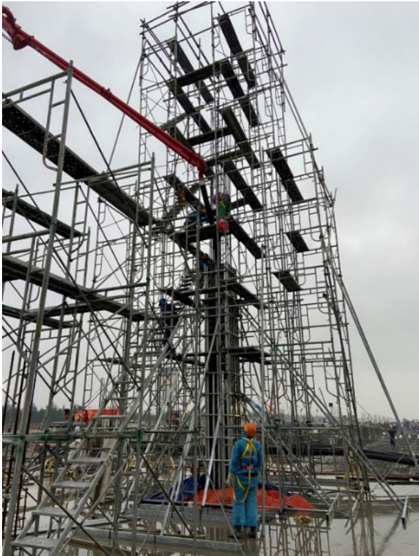
Hình 4. Đổ bê tông cột cao tại công trường
