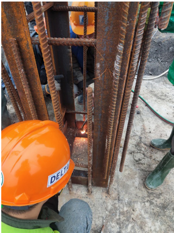
Hình 17. Cố định chân cột bằng liên kết hàn hoặc liên kết bu lông
