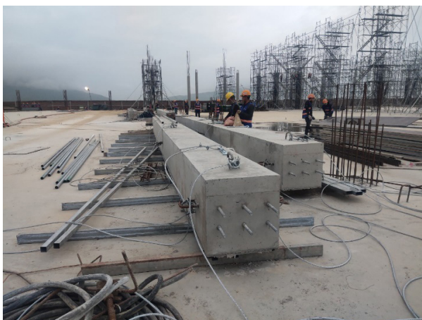
Hình 14. Tháo ván khuôn và chuẩn bị cầu lắp
