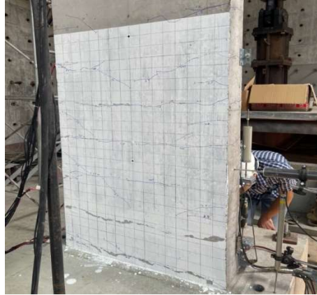
Hình 3.14. Nứt vỡ trong bê tông vách V1 khi dừng thí nghiệm
