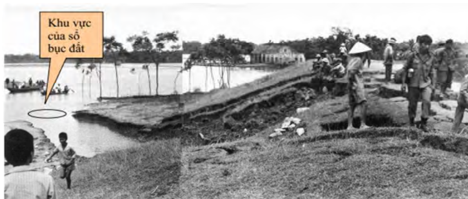
Hình 3.9 Hình ảnh phá huỷ thấm nền đê Vân Cốc - Hà Tây năm 1986 [21, 22]
