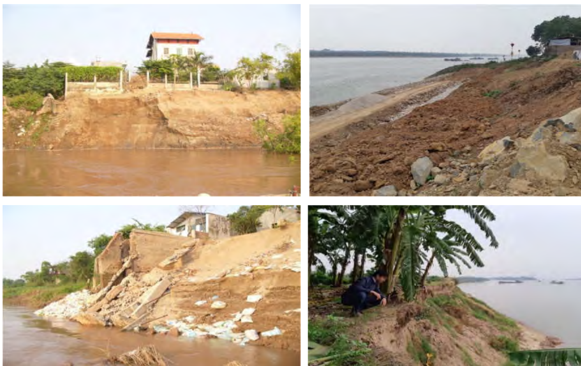
Hình 3.1 Hình ảnh xói lở trên sông Hồng khu vực Hà Nội
