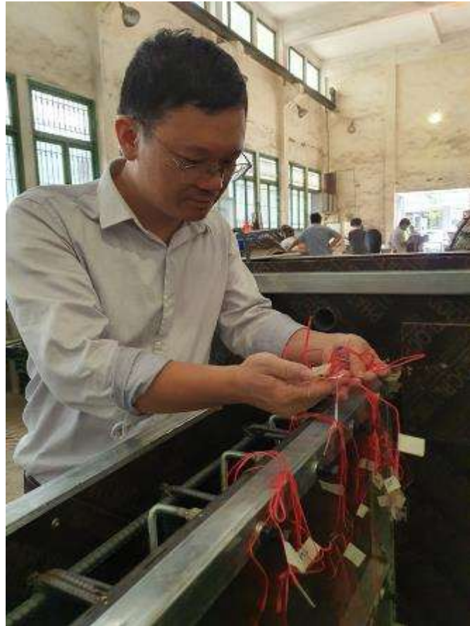
Kiểm tra cốt pha trước khi đổ bê tông
