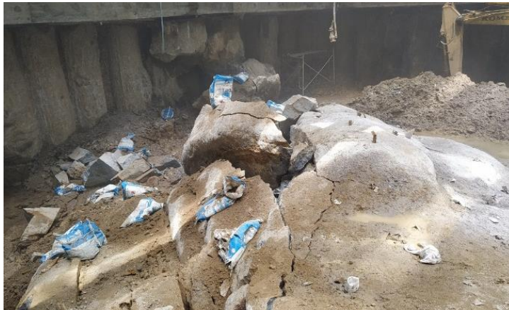
Hình 11. Phá đá bằng bột nở Sino-crack
