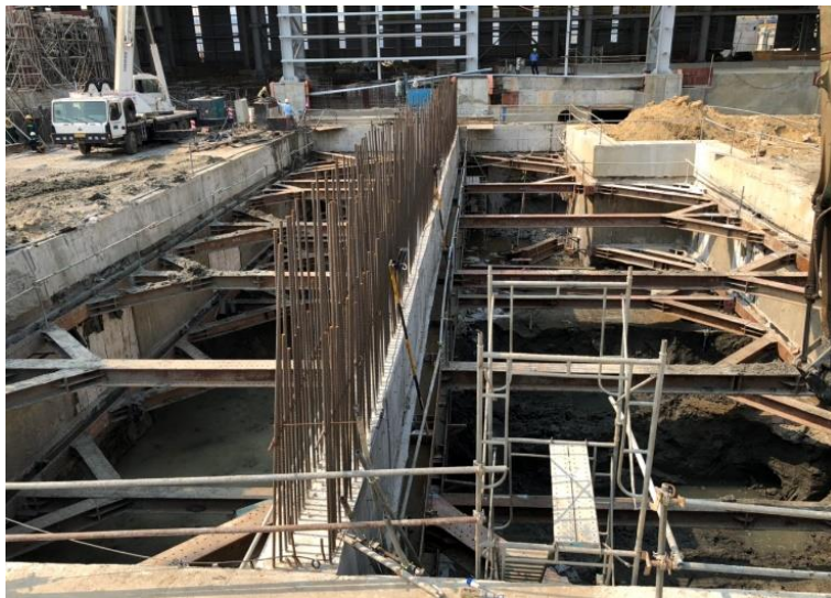
Hình 2. Thi công hố đào Lamina - Cán QSP
