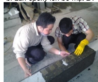
d. Dán tấm lên bề mặt dầm
