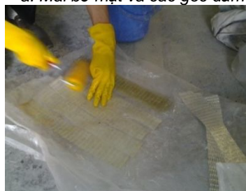
c. Tẩm epoxy vào hai mặt tấm
