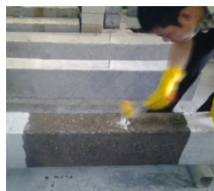
b. Lăn epoxy lên bề mặt BT
