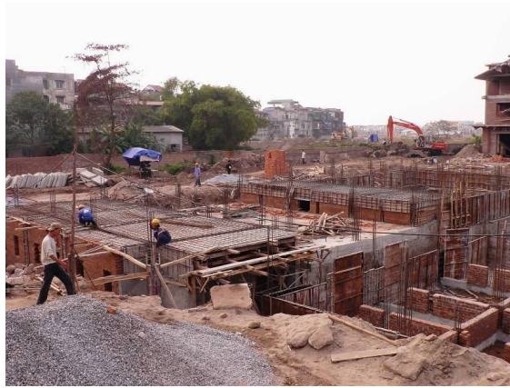
Hình 5. Thi công móng nổi tại khu đô thị mới Bắc Hà
