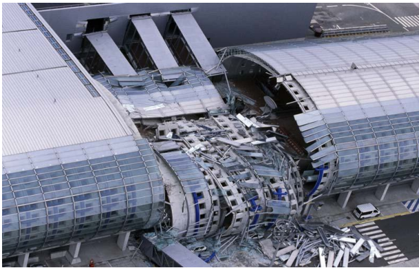
Ảnh 1. Toàn cảnh khu nhà chờ 2E – Sân bay Charles de Gaulle sau khi sụp đổ ngày 23/5/2004
