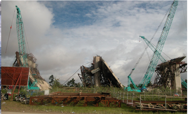
Ảnh 2. Toàn cảnh 2 nhịp neo cầu Cần Thơ sau sự cố sụp đổ ngày 26/9/2007
