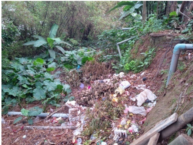
Hình 5. Sạt lở tạo hố sâu gần nhà dân tại xã Đông Quang, người dân đổ rác để lấp
