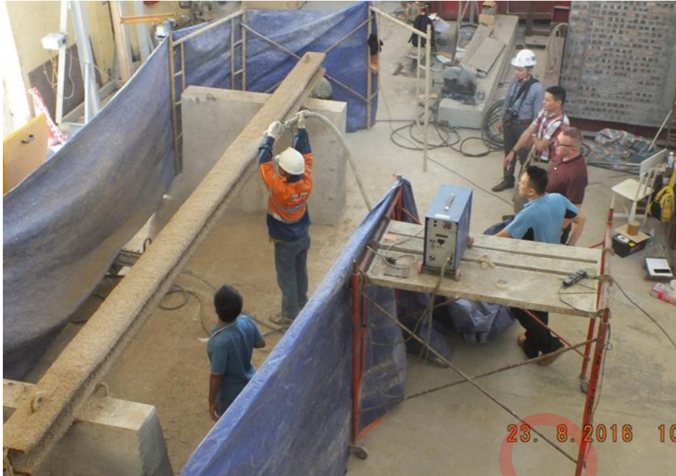
Hình 25 – Ví dụ thi công phun bọc bảo vệ chịu lửa cho dầm thép bằng vữa
