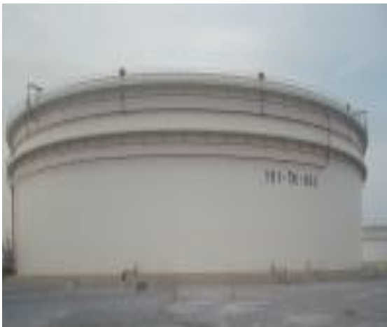
Hình 1. Bồn chứa dầu hình trụ đứng
