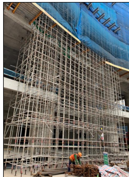
Hình 1. Hệ giáo chống dầm chuyển truyền thống ở một công trình nhà cao tầng
