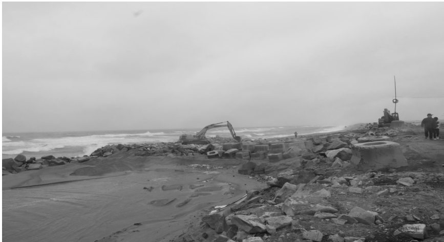
Hình 15. Xói lở làm phá hủy công trình kè chống ven đường bờ biển
