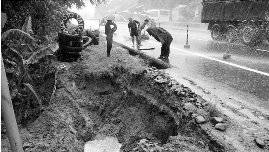
Hình 13. Quốc lộ 1A qua địa bàn tỉnh Phú Yên bị sạt lở nghiêm trọng
