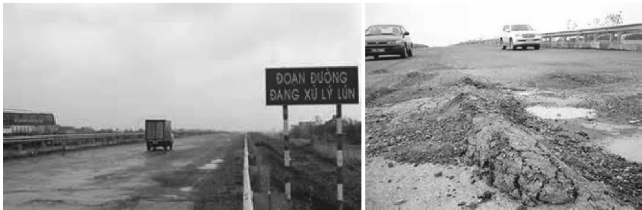
Hình 1. Hư hỏng đặc trưng trên một số tuyến đường
