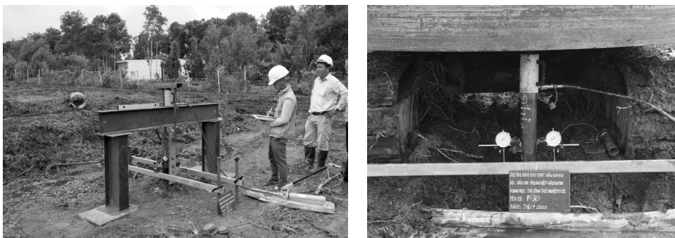
Hình 3. Thi công cọc thử và thí nghiệm cọc thử
