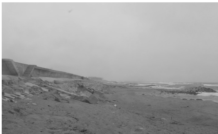
Hình 12. Xói lở làm sập kè bảo vệ, bờ biển có nguy cơ bị phá hủy
