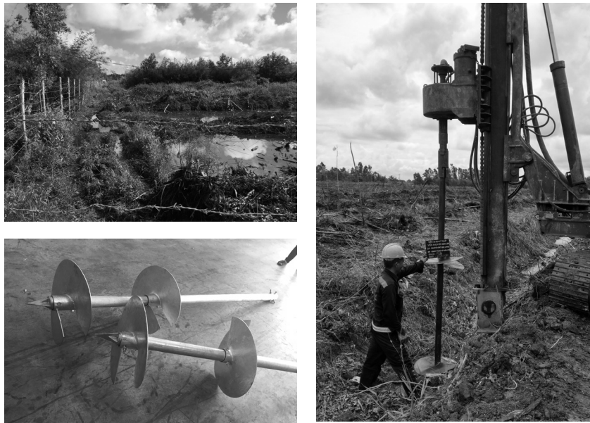
Hình 1. Cọc neo và thi công hạ cọc
