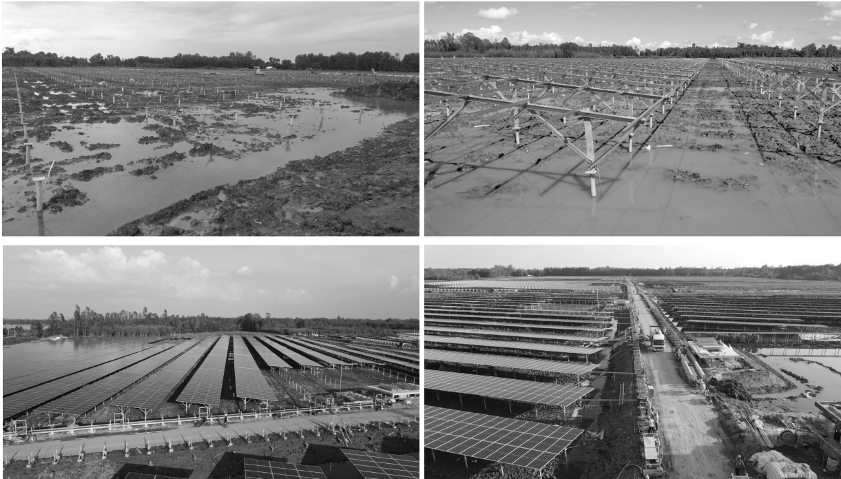
Hình 5. Thi công cọc đại trà tại dự án
