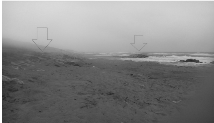
Hình 11. Vị trí bờ kè cũ (bên ngoài) so với bờ kè đang được xây dựng lại (bên trong) khu vực sông
