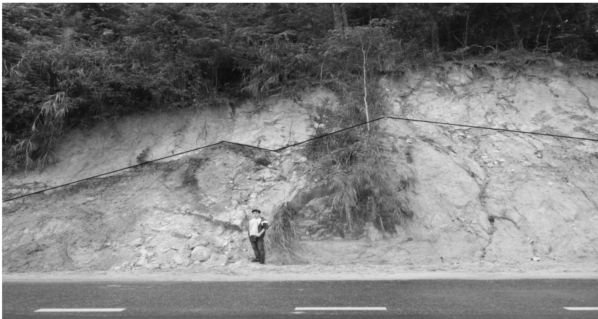
Hình 16. Trượt lở 1 đoạn taluy bên đường giao thông tại huyện Sông Hinh - Phú Yên
