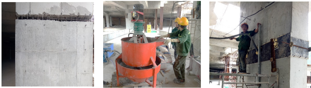
Hình 2. Công tác thi công bơm vữa chèn
