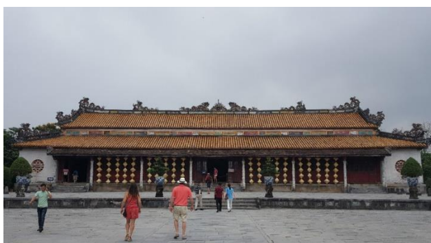
Hình 1. Điện Thái Hòa - mặt trước
