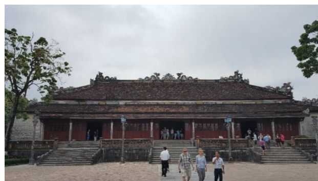
Hình 2. Điện Thái Hòa - mặt sau
