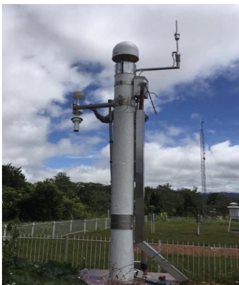
Hình 2. Trạm CORS xây dựng trên mặt đất
