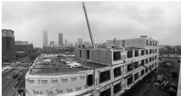
Hình 9. Các công nhân đang kết nối các mô-đun trong quá trình lắp đặt cầu của Bricktown AC by Marriott ở thành phố Oklahoma. Tám mươi mốt mô-đun, tất cả được xây dựng trong nhà máy Boerdon's Boise, đến với nhau để tạo nên khách sạn gồm 142 phòng. Ảnh: Guerdon. [4]
