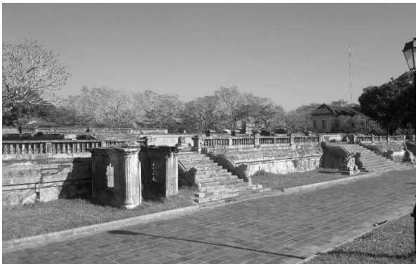
Hình 6. Di tích điện Kiến Trung hiện nay (Nguồn: Phân viện KHCN Xây dựng Miền Trung)
