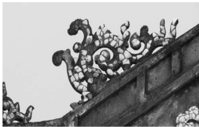
Hình 2. Con giống khảm sành sứ qua loa và các ô hộc được trau màu không khảm
