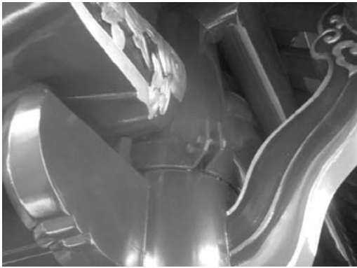
Hình 13. Đai neo cáp chống bão đầu cột cái
