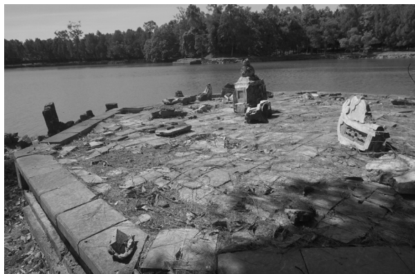
Hình 3. Hiện trạng nền móng Điều Ngự Đình
