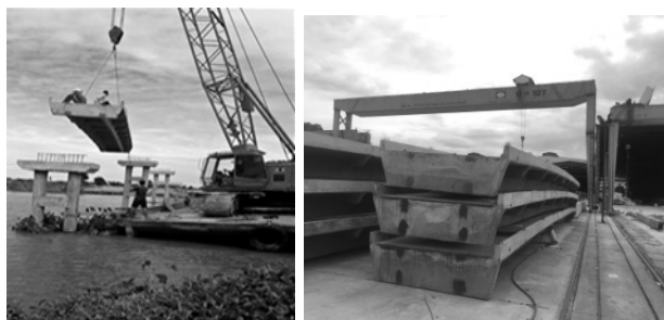
Hình 28: Cầu UHPC Cả Sạch, Tân Hưng, Long An (8/2018)
