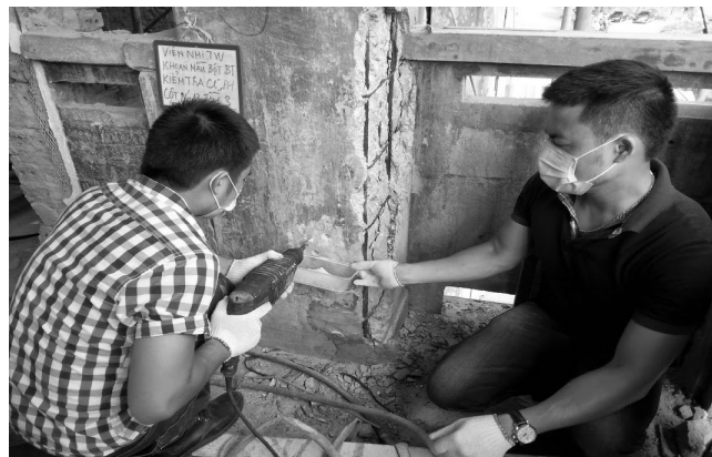
Hình 5. Khoan lấy mẫu bê tông bột kiểm tra hàm lượng clorua, pH
