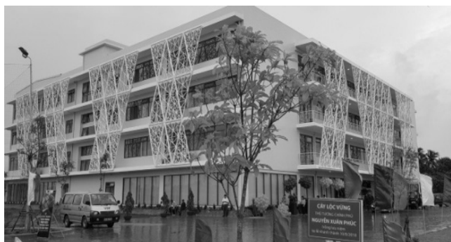
Hình 26: Mặt dựng UHPC cho toàn nhà Beta – Đại học FPT Cần thơ (8/2018)
