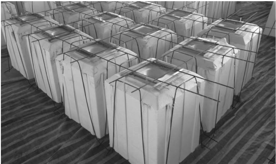
Hình 5. Khối xốp trước khi lắp đặt
