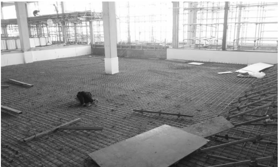
Hình 6. Lắp đặt lớp thép phía dưới
