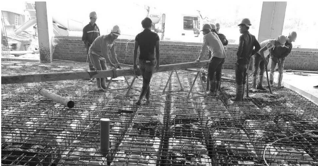
Hình 8. Đổ bê tông
