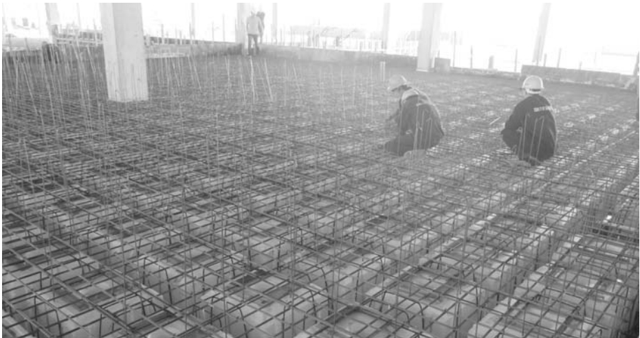
Hình 7. Lắp đặt lớp thép cánh trên
