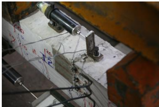
Hình 10. Bê tông vùng nén bị phá vỡ
