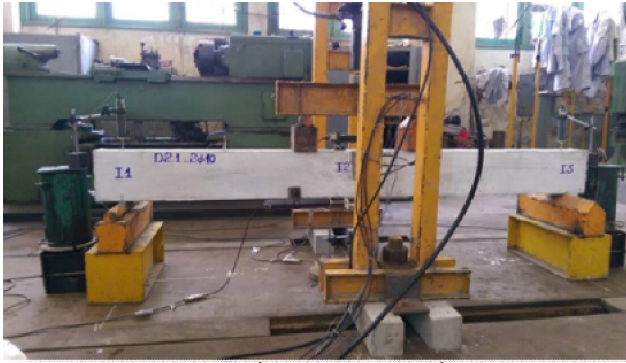
Hình 7. Dầm TN đã hoàn tất cài đặt
