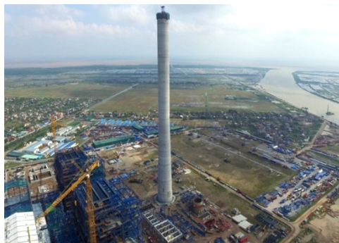
Thẩm tra và TVGS xử lý nền nhà máy nhiệt điện Thái Bình 2
