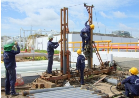
Thiết kế và thi công chống lún cho hệ thống đường ống dẫn khí đốt tại kho cảng Thị Vải – Vũng Tàu
