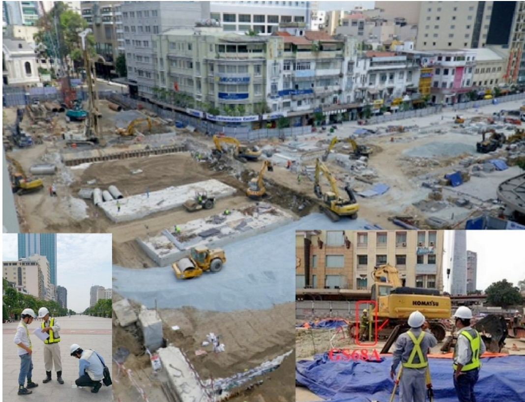
Tư vấn – quan trắc dự án xây dựng tuyến đường sắt đô thị số 1 TP. Hồ Chí Minh
