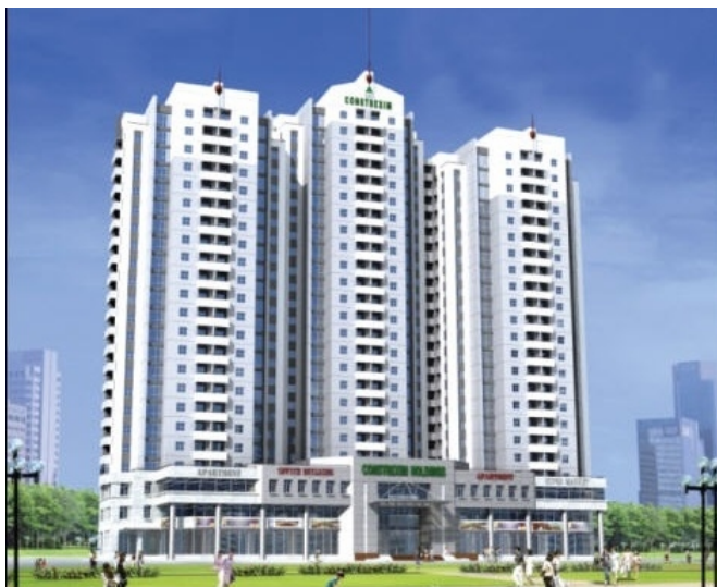
Thẩm tra thiết kế, TVGS công trình khu đô thị Bắc Hà – Thanh Xuân - HN
