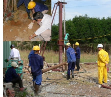
Thi công thử nghiệm công nghệ hạ cọc bằng phương pháp xoắn cọc
