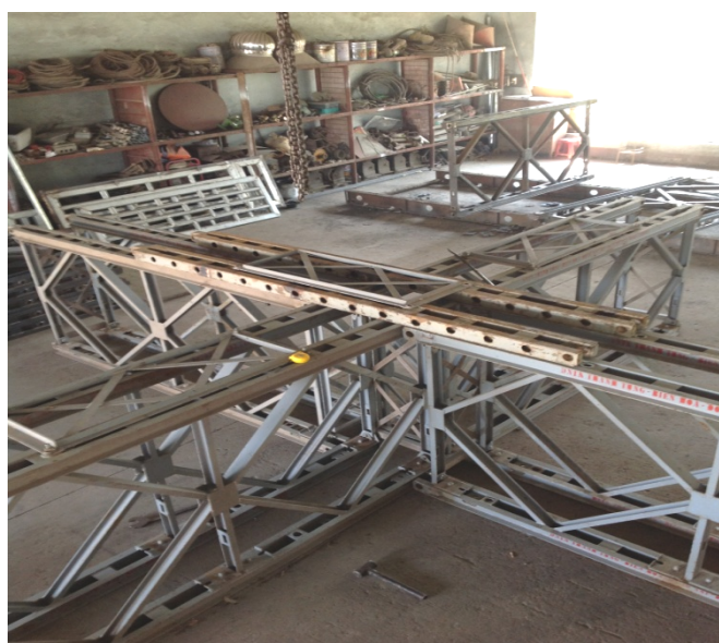
Hình 8. Nút trực giao do tác giả thiết kế tại xưởng sản xuất công ty Thanh Tùng Bailey
