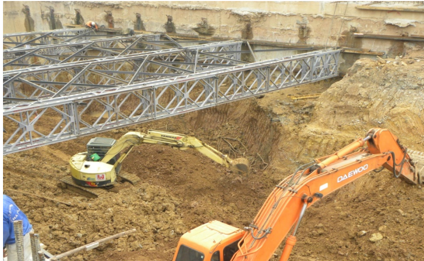
Hình 1. Hệ thống văng chống vách hố đào tầng hầm bằng dầm Bailey lắp song song (Tòa nhà Sun square đường Lê Đức Thọ)
