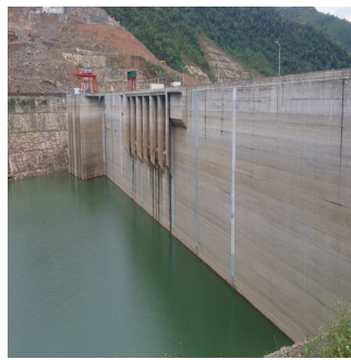
Hình 15. Phun polyurea chống thấm Đập TĐ Bản Vẽ
