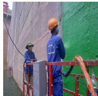
Hình 16. Phun polyurea chống thấm Đập TĐ Bản Chát
