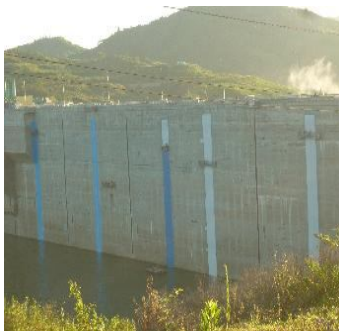
Hình 14. Phun polyurea chống thấm Đập TĐ Sông Tranh 2
