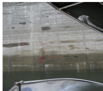
Hình 12. Vết nứt tại khe biến dạng
