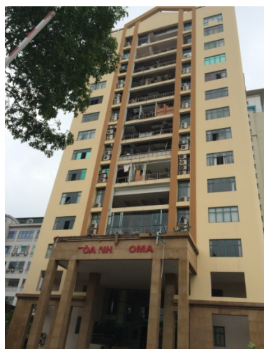
Hình 3. Toàn bộ phần kính mặt đứng tòa nhà tại 125D Minh Khai, Hà Nội bị rơi xuống đất (ảnh chụp sau cơn giông ngày 13/6/2015)
